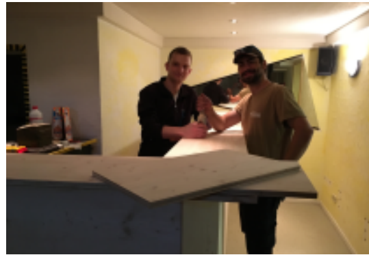
Der Einbau läuft auf vollen Touren.
